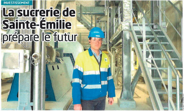
Vincent Lagasse, le directeur, est fier du nouveau système de production d'énergie de la sucrerie de Sainte-Émilie.
